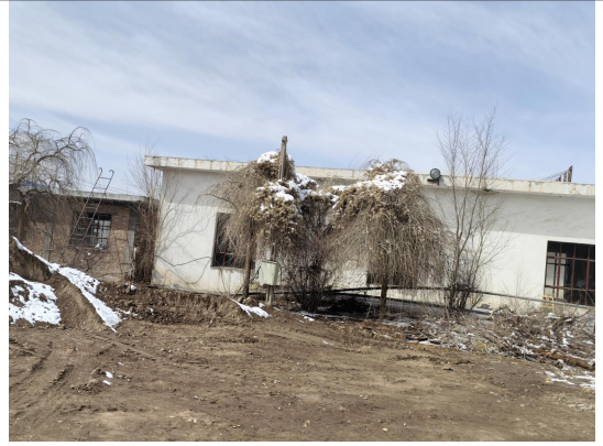
蓄水池西侧自来水公司管理用房
