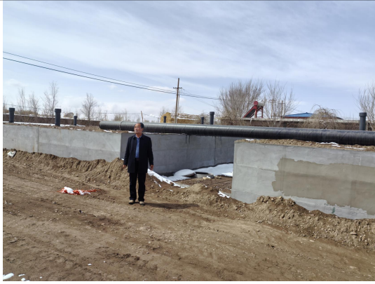
清泉水厂蓄水池
