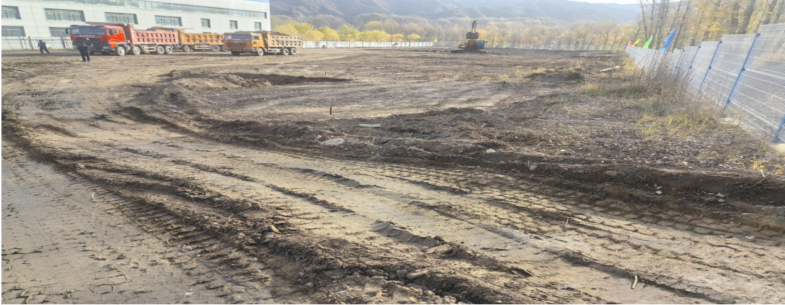
扩建二水厂建设场地
