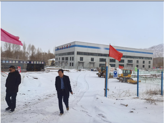
扩建二水厂厂界北侧
